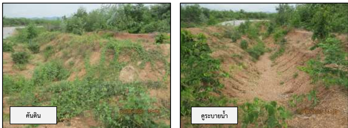
ภาพที่ 2.14 คันดินอัดแน่น และคูระบายน้ำของโครงการ
